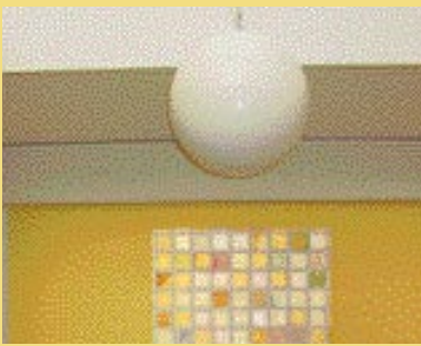
Mit einer Heizkugel strahlt die Wärme auch optisch markant nach allen Seiten.
