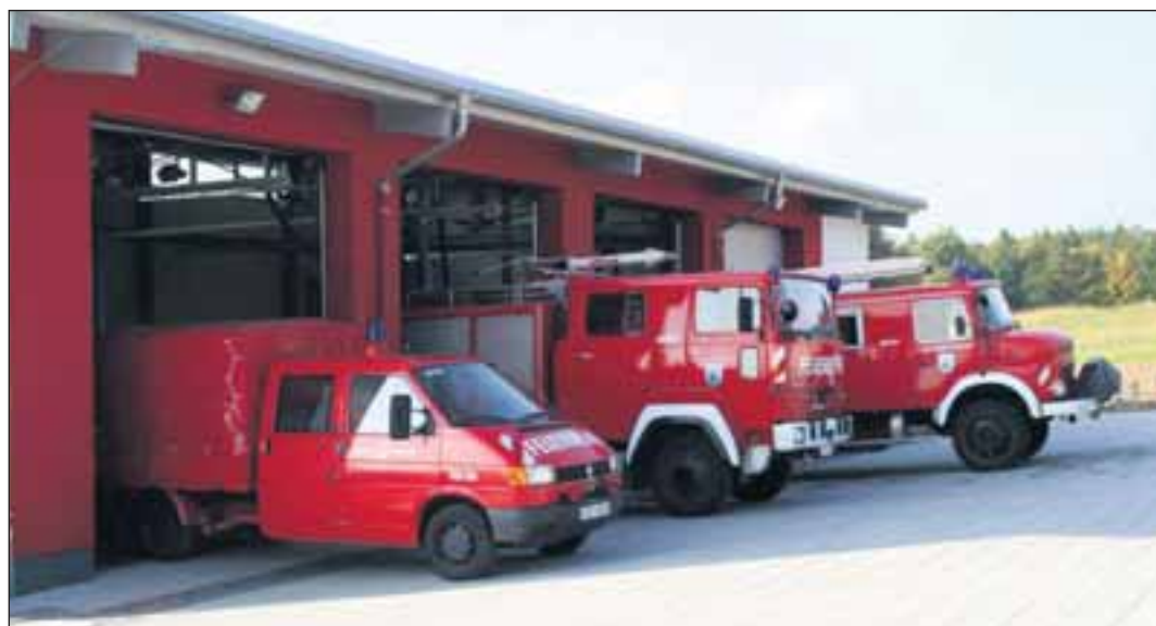
Ein Schmuckstück: Das neue Feuerwehrgerätehaus in Bad Emstal-Sand ist in zwei Komplexe eingeteilt und wird am Sonntag, 14. Oktober, eingeweiht. Foto: Hellwig
